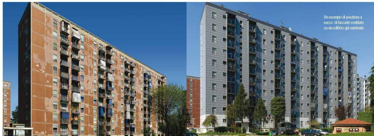
Un esempio di posatura a secco di facciate ventilate su un edificio già esistente
